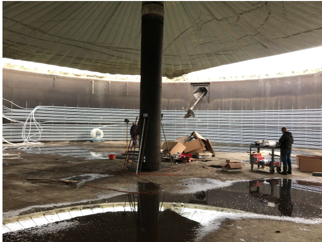
Interno dei digestori con sistemi di miscelazione e sistemi di riscaldamento
